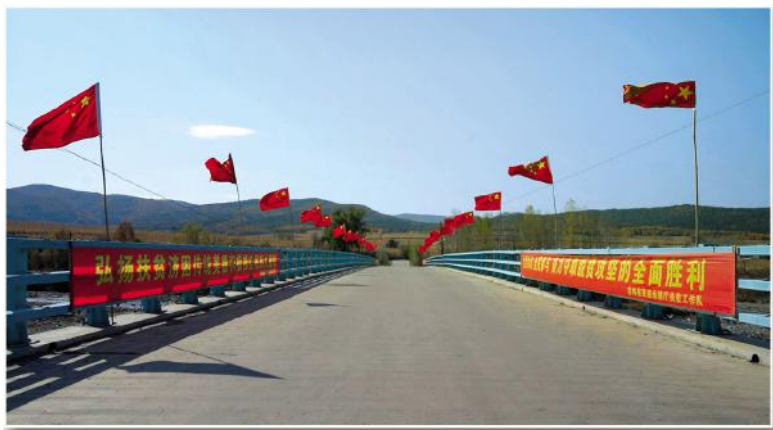
新建设的明东桥
