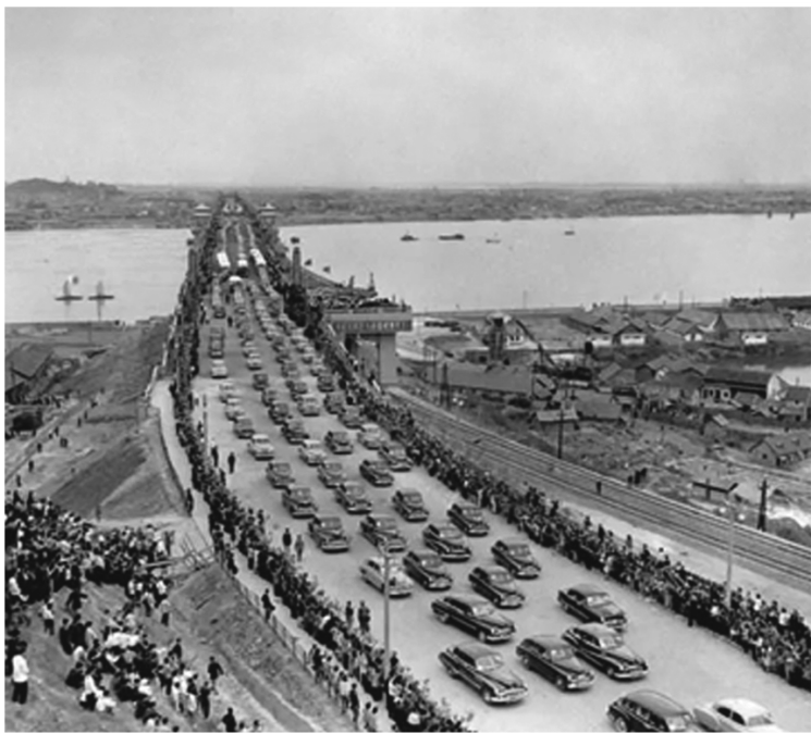
1957 年 10 月 15 日,武汉长江大桥建成通车
